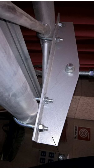
SOSTITUZIONE AGGANCI ESISTENTI AMERICANA CON LAME IN ACCIAIO ACCOPPIATE
