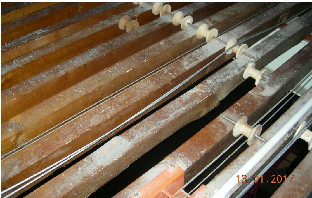
Foto n.05 - Particolare del graticcio in legno
